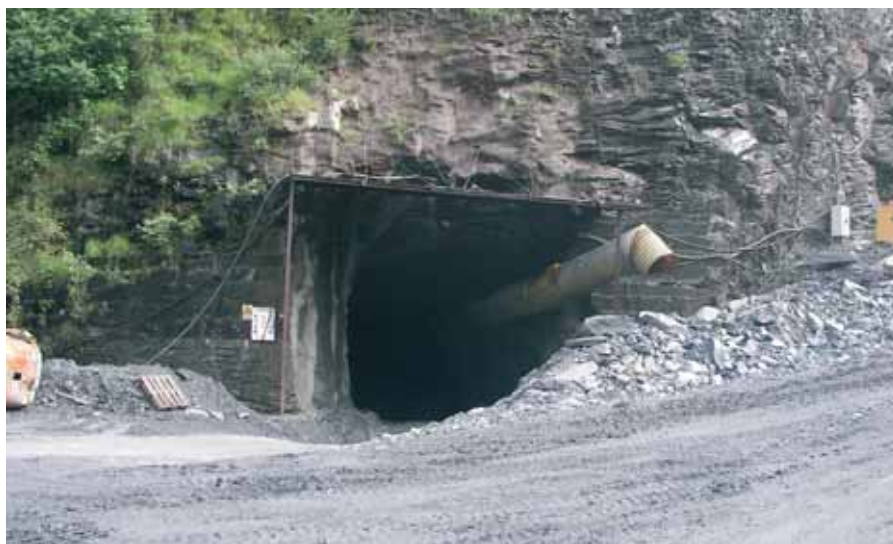
Entrada mina subterránea de Lousas Gallegas
